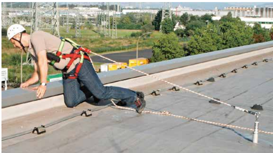
▲ Risiko am Dachrand: Wenn der Anschlagpunkt nicht einwandfrei ist, droht Lebensgefahr
